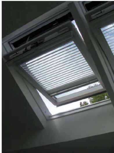
Les Velux du studio B se referment automatiquement en cas de pluie grâce à des capteurs qui fonctionnent comme les essuie-glaces automatiques des pare-brise des voitures.
