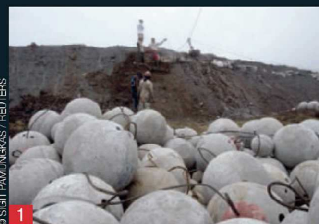
1 Renforcer. Ces boules de béton permettent de renforcer les digues.
