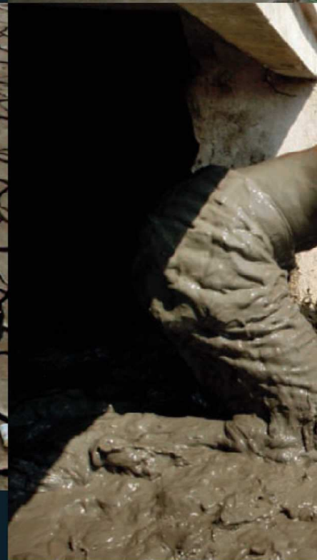
Désolation. Ici, plus rien ne pousse, en raison des hydrocarbures.
